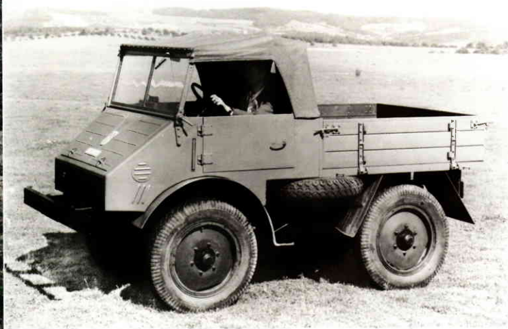
ה'אונימוג' הראשון יוצר על-ידי האחים בורנגר עבור מרצדס-בנץ. בסה"כ יוצרו 600 עותקים בין השנים 1949-1951, אז הועבר הייצור למפעלי מרצדס המשוקמים, במקביל לעליה חדה בביקוש לרכבי השטח/טרקטורים הקשוחים הללו. הדגמים הראשונים צויזו במנוע עם 25 כ"ס, שהספקו צמח מאוחר יותר ל-30 כ"ס
